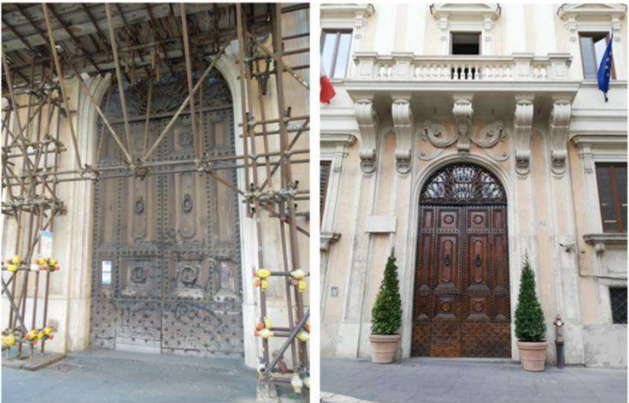
Ingresso Viscontino – ante e post operam
