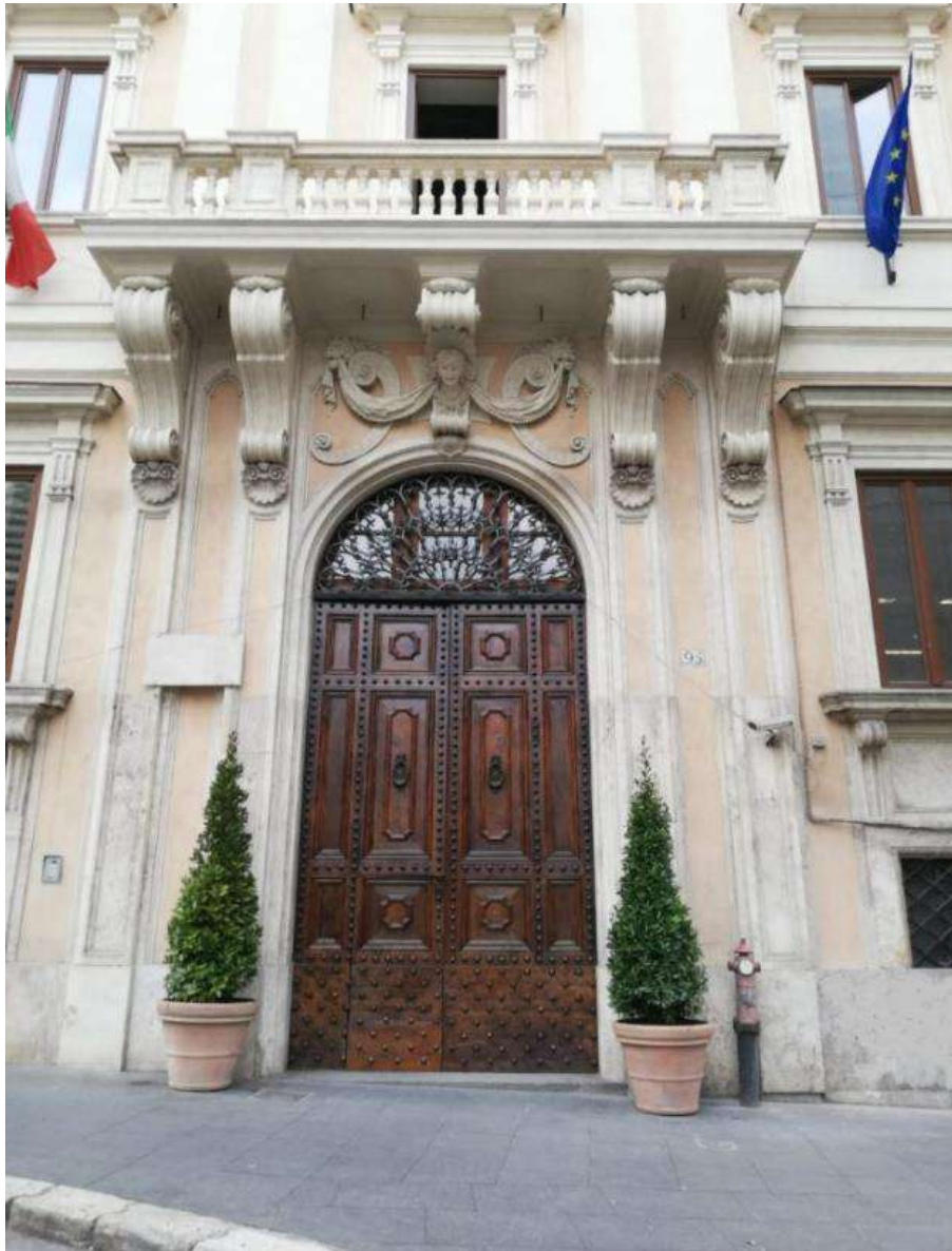
Ingresso Viscontino dopo messa in sicurezza
