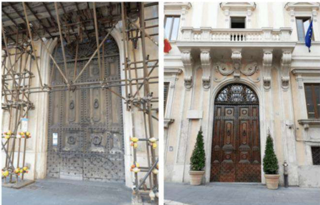
Ingresso Viscontino – ante e post operam
