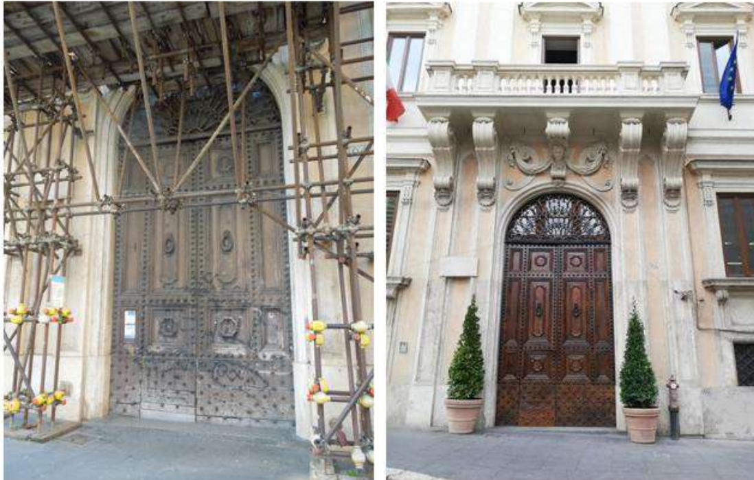
Ingresso Viscontino – ante e post operam
