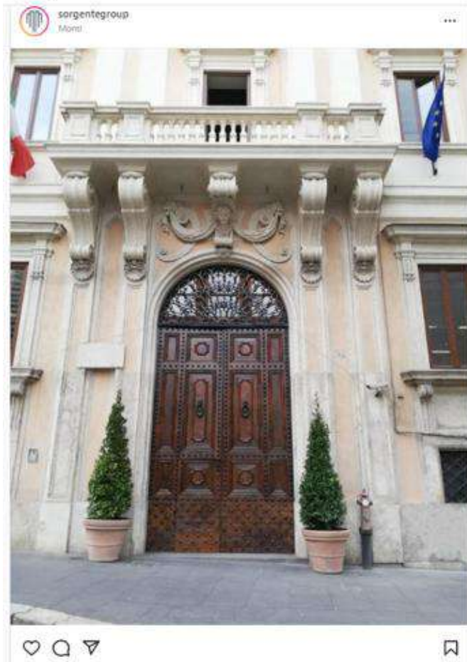
sorgentegroup - Conclusi i lavori di messa in sicurezza del Viscontino. La scuola torna alla sua antica bellezza, grazie a Sorgente Rem
