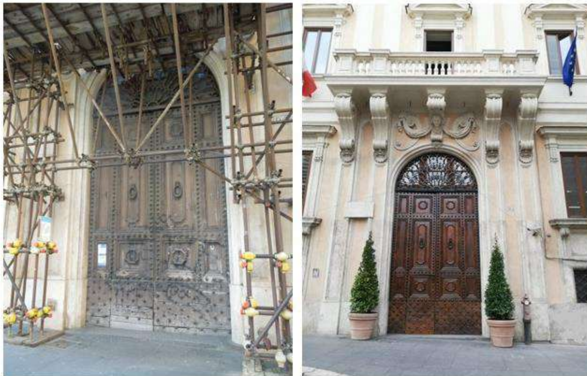
Ingresso Viscontino – ante e post operam
